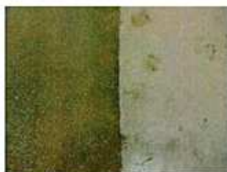
(写真2 前処理室床) 左側が滑りにくい床材です。
