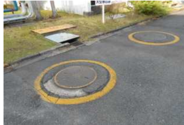
路面の段差は黄色で注意喚起
