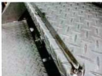
(写真3 キー材溶接)
