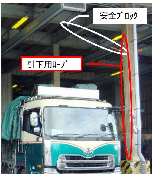
(写真2)安全ブロックと引下用ロープ
