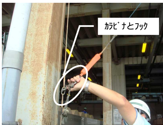
(写真3)引き下げられた安全ブロックのフック
