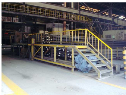
(写真4)10t車用プラットホーム
