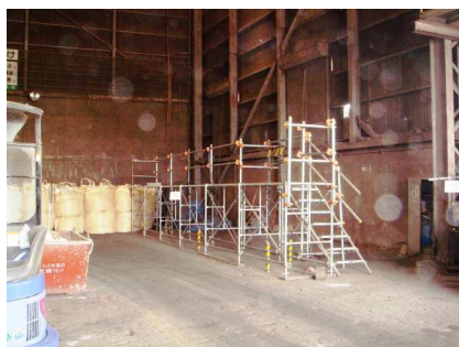
(写真5)トレーラ用プラットホーム
