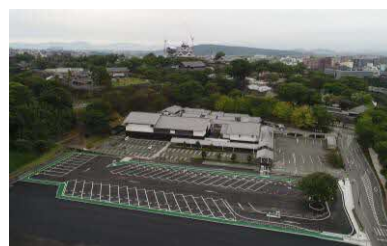
合同庁舎跡地駐車場整備工事
