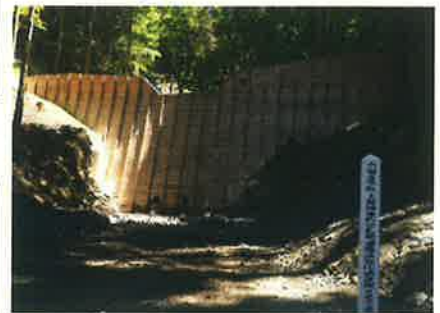
令和4年度上益城管内災害関連 緊急治山事業第4号工事 令和7年度熊本県治山林道協会表彰受賞
