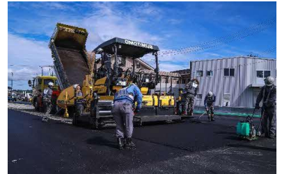
舗装工事の様子
