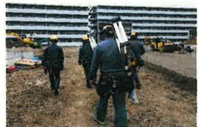
災害住宅工事風景
