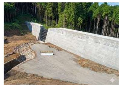
完成現場様子
