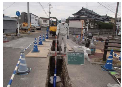
現場の作業風景
