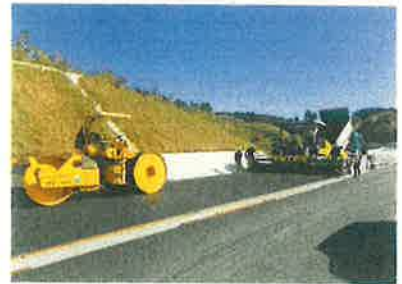
舗装工事の様子
