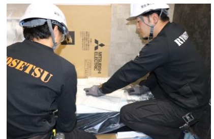
空調機試運転作業の様子
