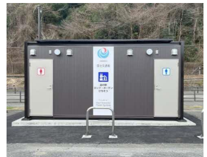
災害用バイオトイレ
