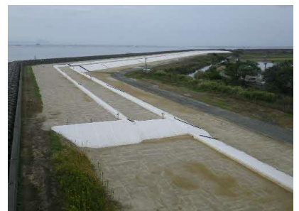
九州農政局発注堤防盛土工事完成
