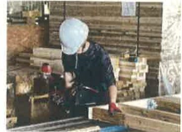
壁パネル製作
