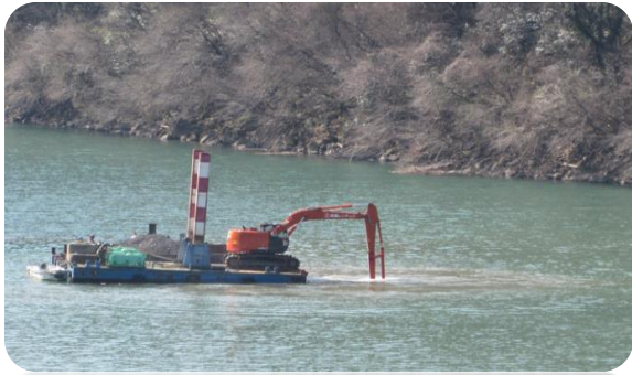
PDバックホウ船しゅんせつ作業
