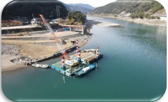
PDバックホウ船しゅんせつ作業
