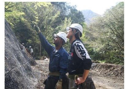
現場での打ち合わせ風景
