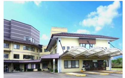
介護老人保健施設の外観
