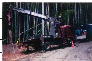
岩盤掘削車を使用しての作業
