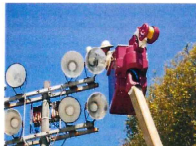
高所作業車を使用しての作業
