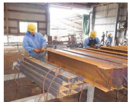
工場内作業写真2
