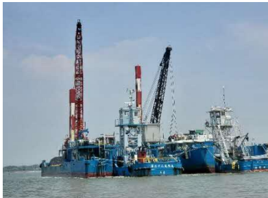
海上工事の様子
