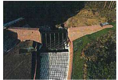
完成した堰堤工事
