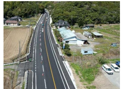
舗装工事完成写真
