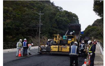
舗装工事の様子
