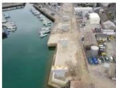
完成した橋脚工事
