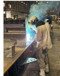
溶接作業風景
