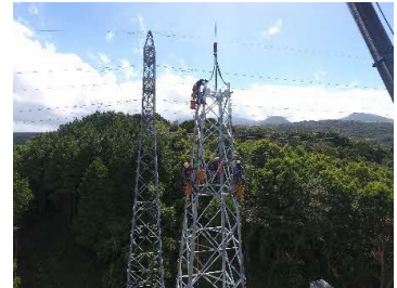
工事作業の様子
