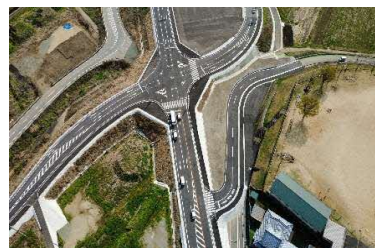
大津植木線広域連携交付金（道路改築） 道路改良その2工事
