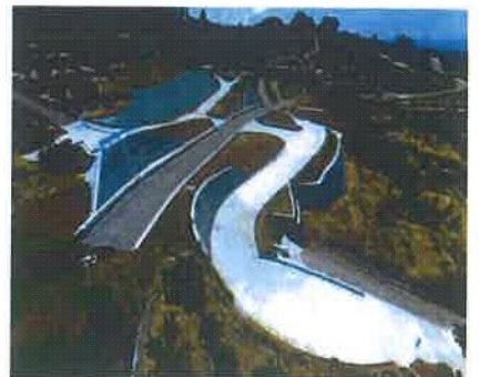
施工工事写真
