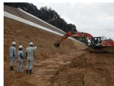
現場での作業風景
