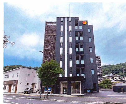
熊本駅前テナントビル
