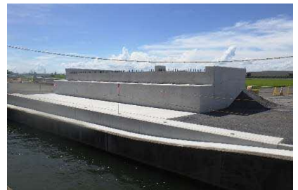
工事現場の様子（橋台施工）
