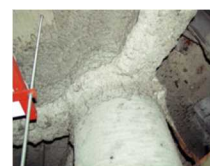
吹付け石綿 （鉄骨材の耐火被覆）
