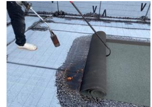
アスファルト防水工事の様子
