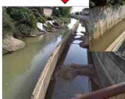
通水状況(用・排水路)(8月14日) 【八代市敷川内町】
