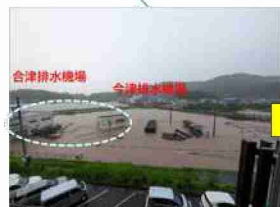
排水機場の浸水 【上天草市松島町】
