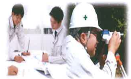
打合せ及び測量中
