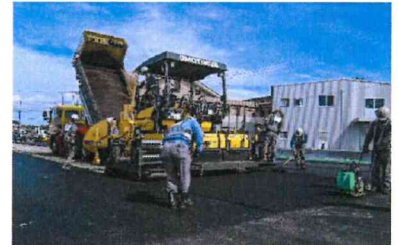
舗装工事の様子
