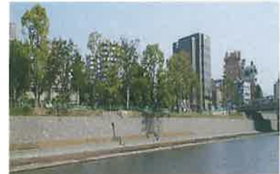
白川大江護岸工事
