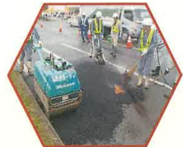
熊本地震復興工事：田井ノ島交差点
