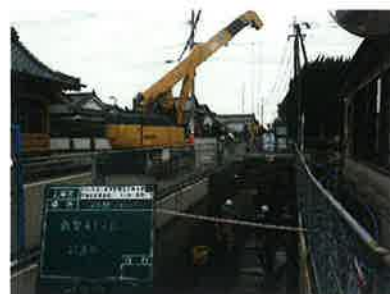
直営作業状況（水路工事）
