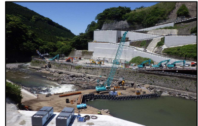
施工実績（令和5年度 立野ダム 管理施設整備その他工事）
