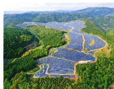
土木工事の施工事例
