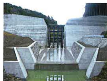
工事現場完成写真
