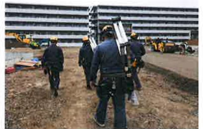
災害住宅工事風景
