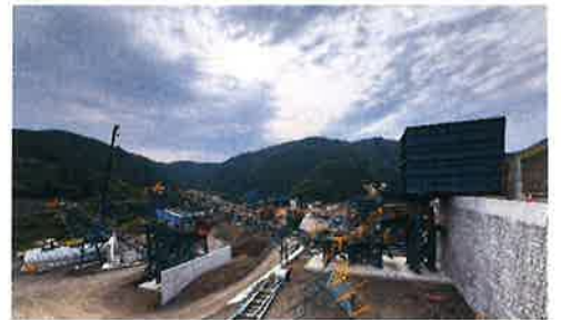
《最新プラント建設中：R7年6月》
