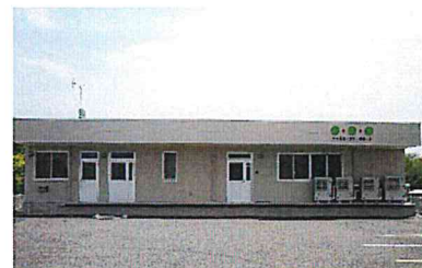
給食センター錦工場の外観
