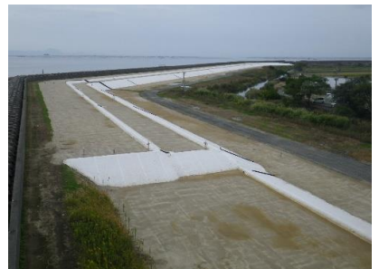
九州農政局発注堤防盛土工事完成
