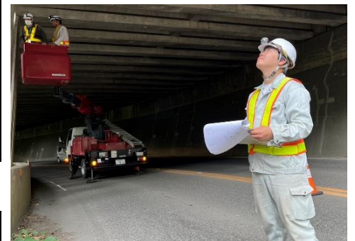
橋梁点検作業
