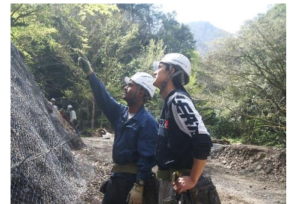
現場での打ち合わせ風景
