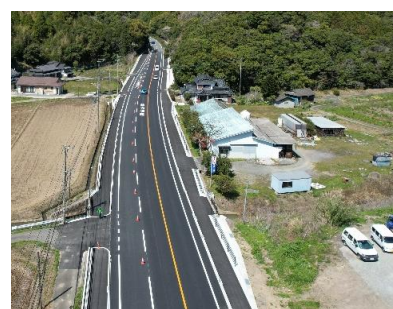
舗装工事完成写真
