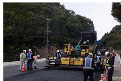
舗装工事の様子
