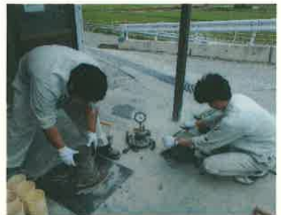
生コンクリート試験の様子
