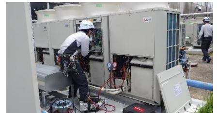
空調機試運転作業の様子
