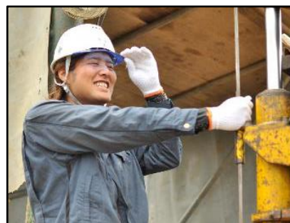
<井戸掘削機操作中！>
