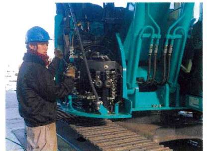
ショベル整備中の様子
